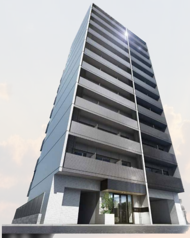
— Log永代橋 — 東京メトロ東西線 門前仲町駅
